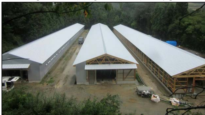
【「かつらお農場」の鶏舎3棟の外観】
