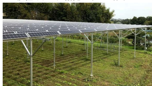
設置された太陽光パネルの様子
