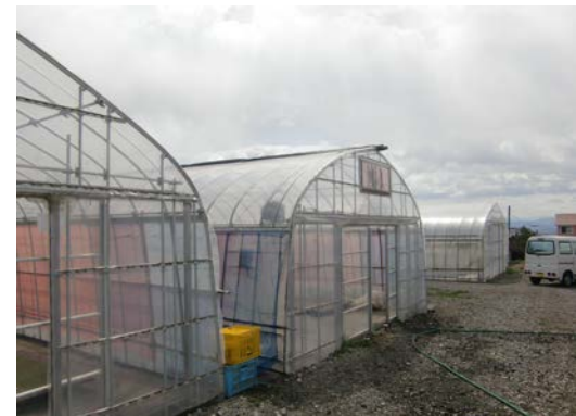
【再建後のハウス】
